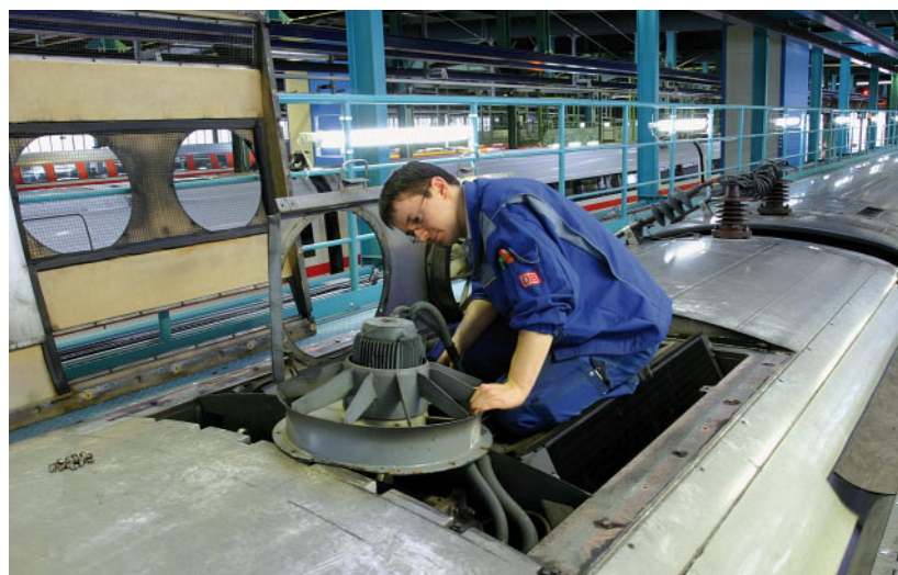
Wartung einer ICE-Klimaanlage im Instandhaltungswerk Frankfurt am Main: Bekommt die Bahn ihre technischen Probleme in den Griff?
